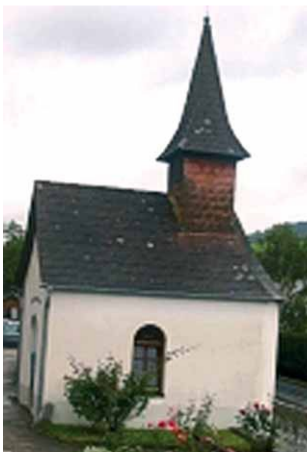
Capilla construída en el lugar exacto donde fue hallada la Hostia
