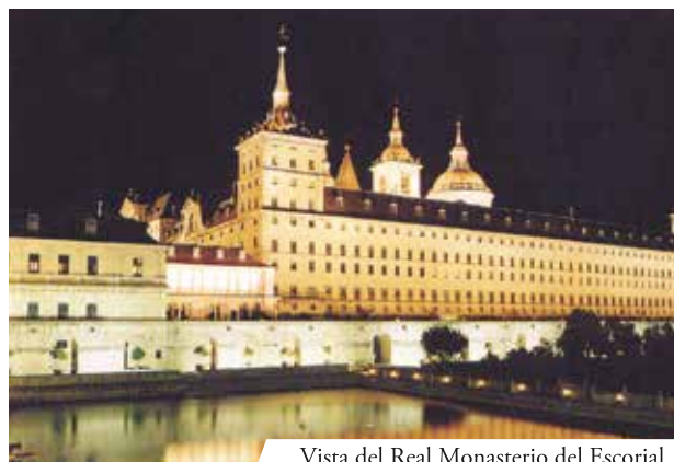
Vista del Real Monasterio del Escorial
